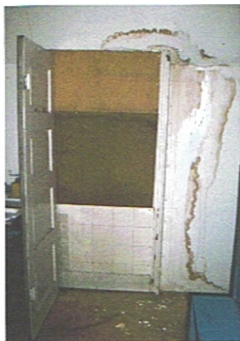
foto 6 i 7. Mieszkanie nr 7 (pod strychem) Wielokrotne, w przeciągu wielu lat ślady zalewania. Spruckniała i wypoczona ościeżnica drzwi.
