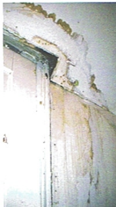
foto 6 i 7. Mieszkanie nr 7 (pod strychem) Wielokrotne, w przeciągu wielu lat ślady zalewania. Spruckniała i wypoczona ościeżnica drzwi.
