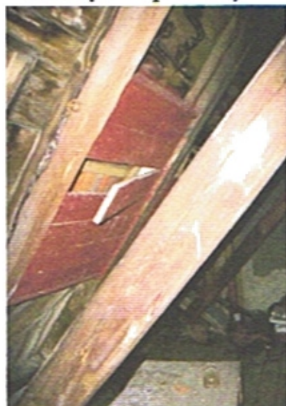
foto 1. Strych, oderwane deski, widoczne dachówki, zacieki na deskach
