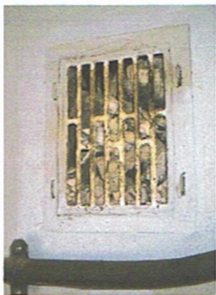
foto 10 i 11. Mieszkanie nr 7. Zasypane gruzem budowlanym przewody wentylacyjne.
