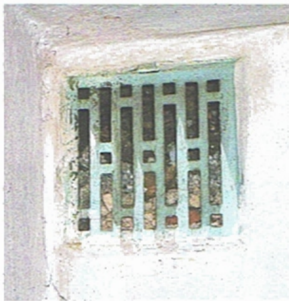
foto 10 i 11. Mieszkanie nr 7. Zasypane gruzem budowlanym przewody wentylacyjne.
