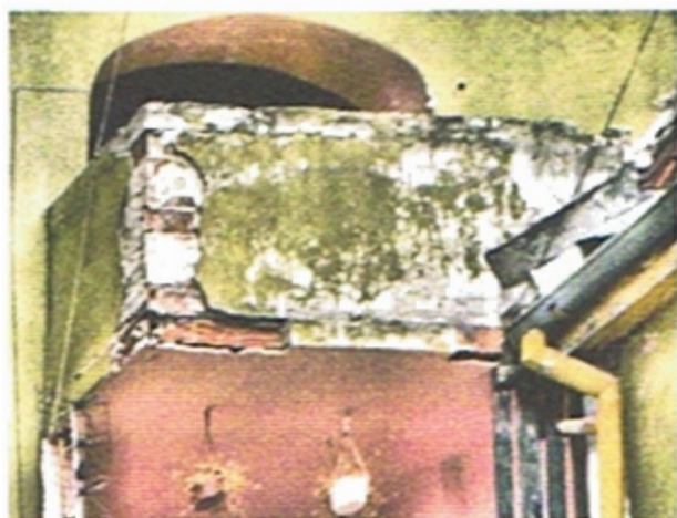
foto 8. Odpadający tynk.
